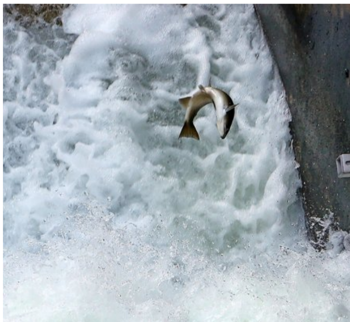
Les turbines du barrage provoquaient un appel d'eau. S.FEVAL
