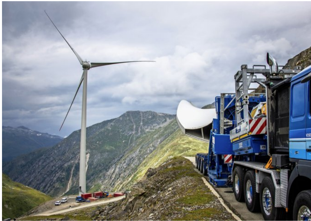
Installation d'éoliennes au col du Nufenen en Valais. KEYSTONE
