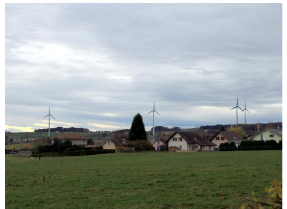
Le projet EssairVent vu depuis l'EMS de Gimel
