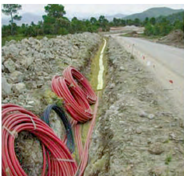
Première intervention brutale: la pose du câble de liaison du complexe éolien.
