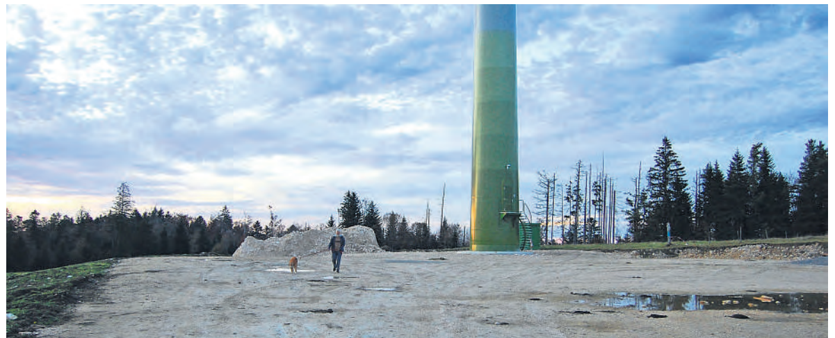
L'érection de parcs d'éoliennes conduit à la désolation de paysages définitivement abîmés.
