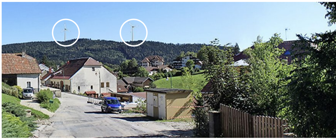
Les mâts prévus sur la crête de Bel Coster, vues ici depuis Jougue (F), ont encore du chemin à faire. Dernière étape en date, une consultation transfrontalière concertée entre les parties s'achève de manière pour le moins tranchée. DR/MONTAGE
