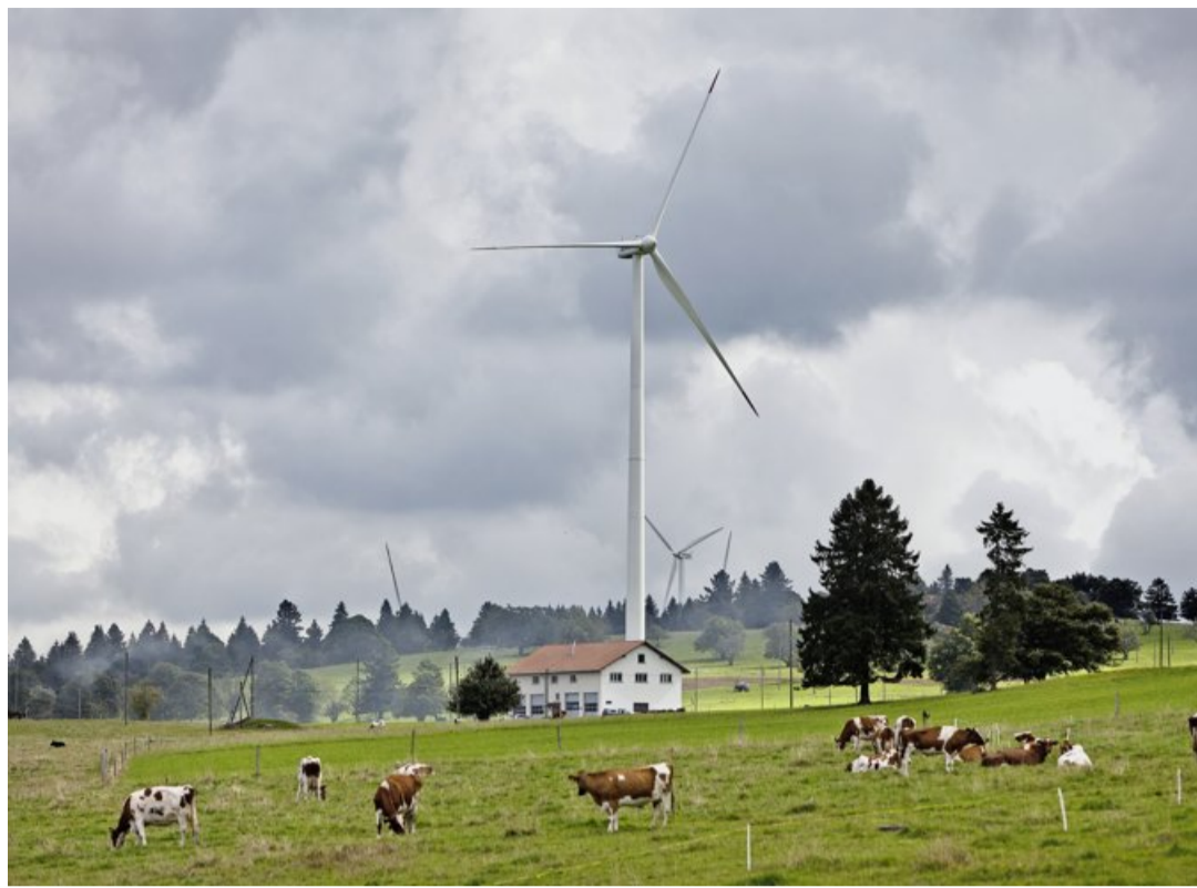
Le parc éolien de Mont-Crosin, vers Saint-Imier, qui comporte seize turbines. KEYSTONE
